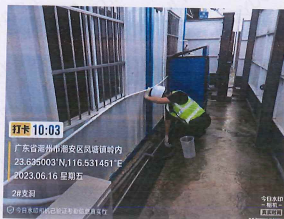
2#支洞生活污水
