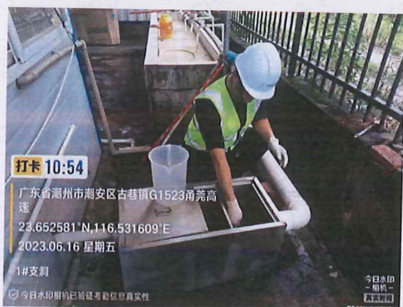
1#支洞生活污水
