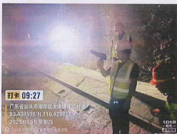
TBM 隧道洞口开端 50 米处
