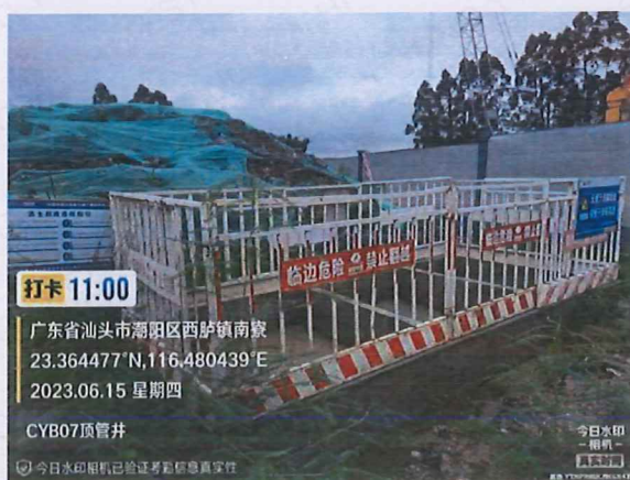
CYB07 顶管井生产废水
