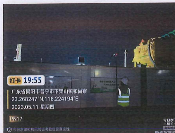
PN17 顶管井南侧厂界外 1 米 2#
