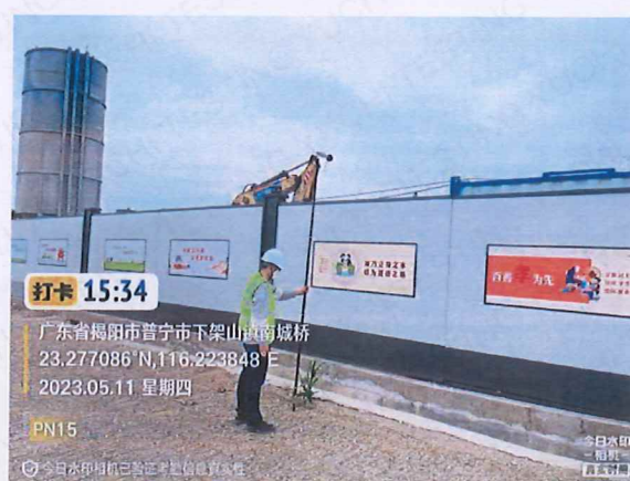
PN15 顶管井东侧厂界外 1 米 2#
