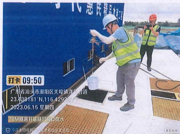
TBM 开端隧洞排水
