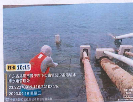
汤坑水库取水口
