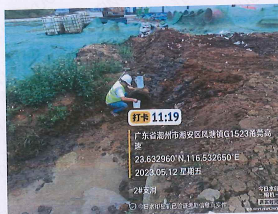
2#支洞化粪池出水口
