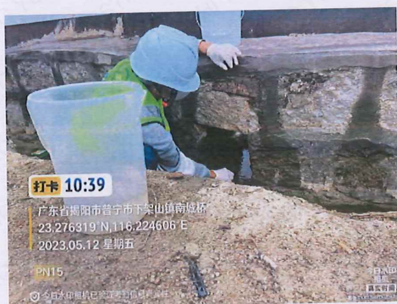
PN15 顶管井化粪池出水口
